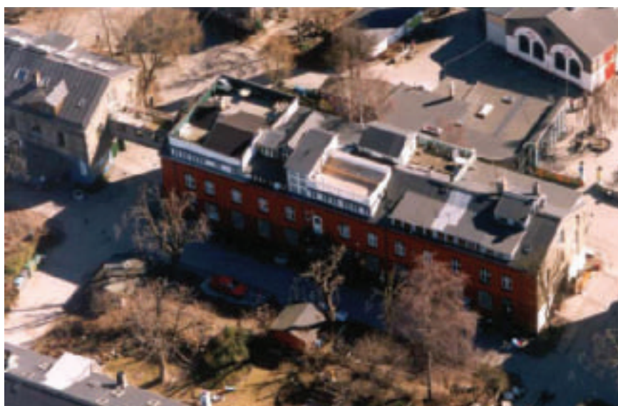
Bygning i Mælkevejen med eksempel på udbygning i tag-etagen
