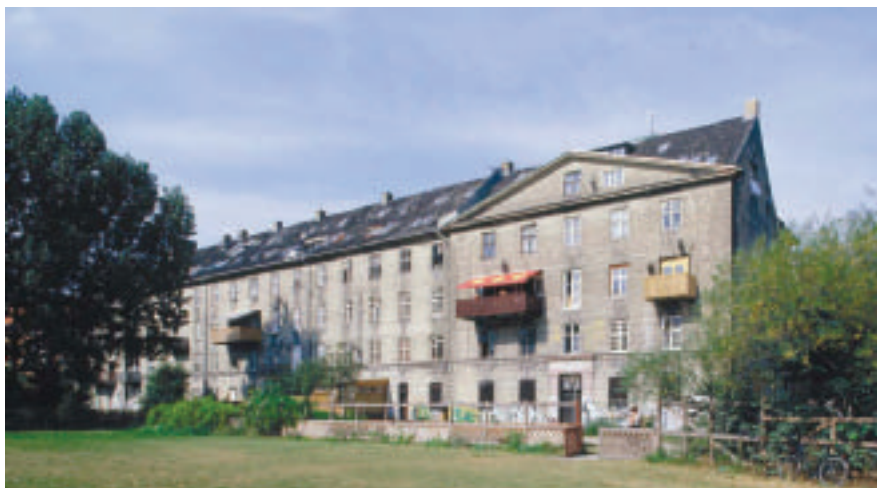
Fredens Ark ligger ud til boldbanen. Den store bygningskrop har fået flere store altaner og mange tagvinduer
